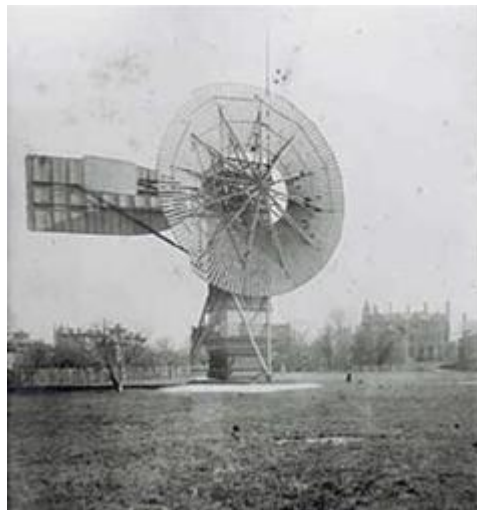
Fig. 1.5 Fuente: Curso energía eólica OLADE Capev 7 2010 Aerogenerador de 12 Kw. creado a finales del siglo XIX
