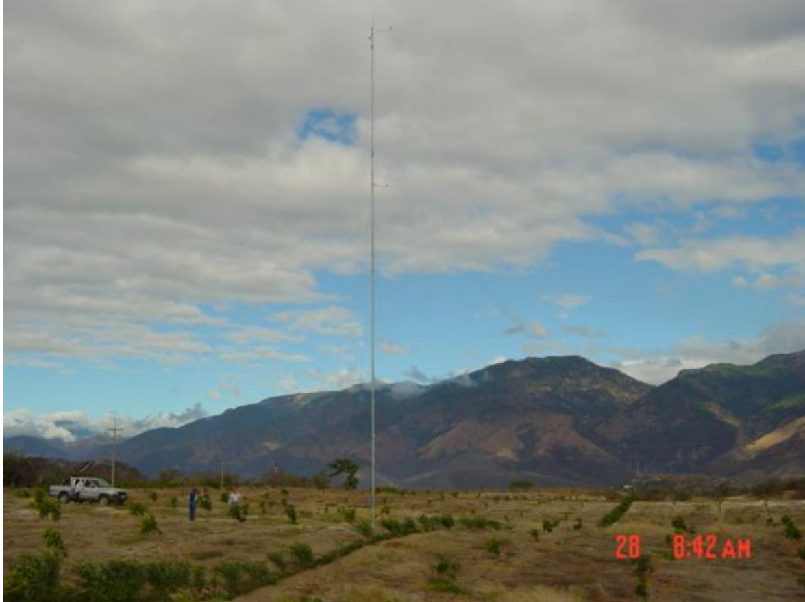
Fig. 2.4 Torre de medición eólica instalada en Estanzuela, Zacapa Fuente: Guía del inversionista 2010. Resumen de Mediciones. Dirección General de Energía Ministerio de Energía y Minas
