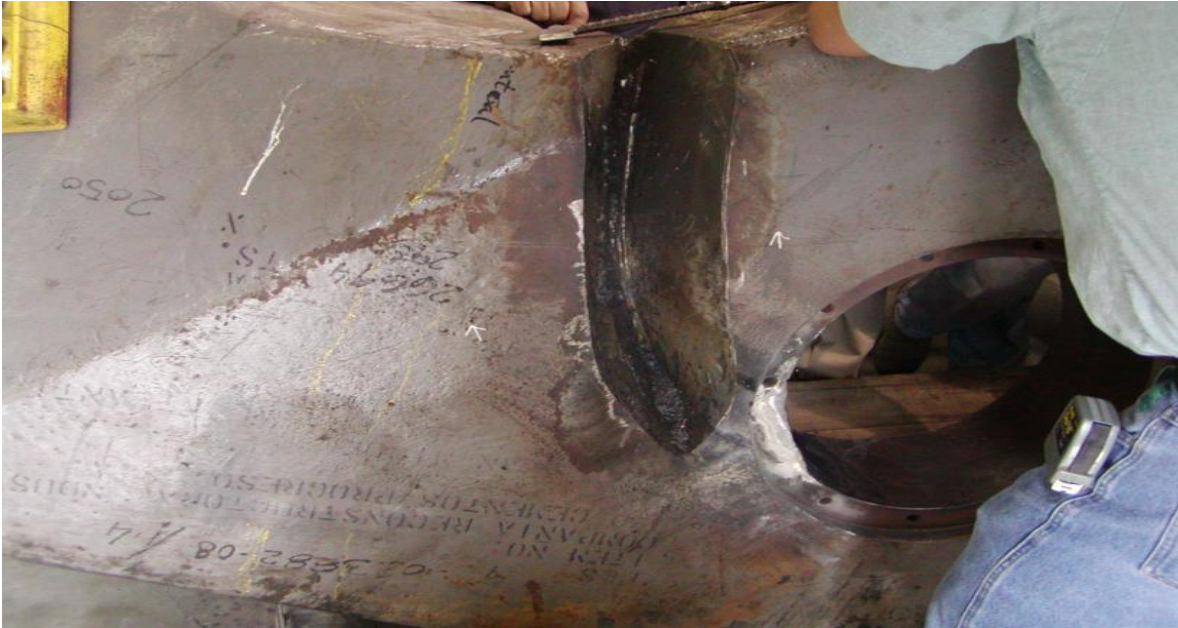
Fig. 3. Diseño y ejecución del bisel necesario para la reconstrucción.
