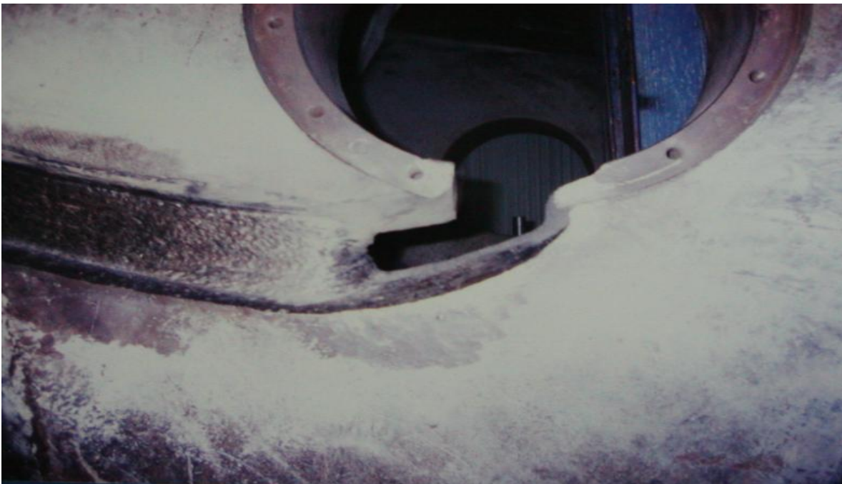
Fig. 4. Ejecución de la Reconstrucción por soldadura.
