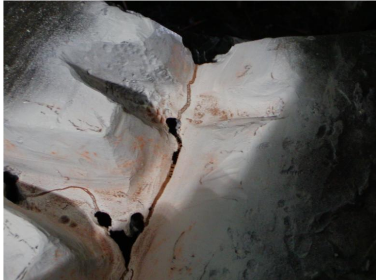
Fig. 4. Zona de reconstrucción lista para iniciar la soldadura.
