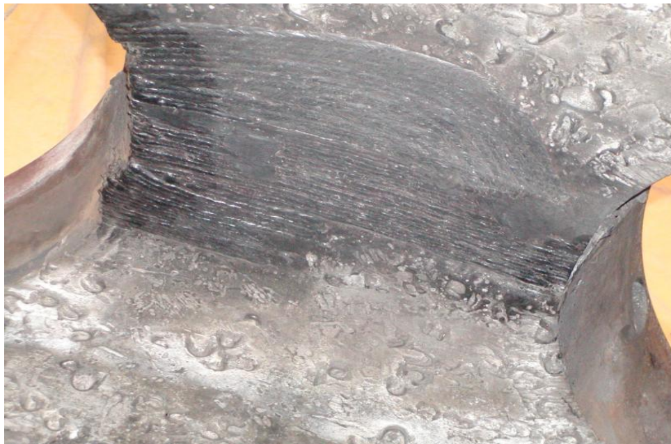
Fig. 8. Presentación final de una reparación, por uno de los lados externos del casco del horno.
