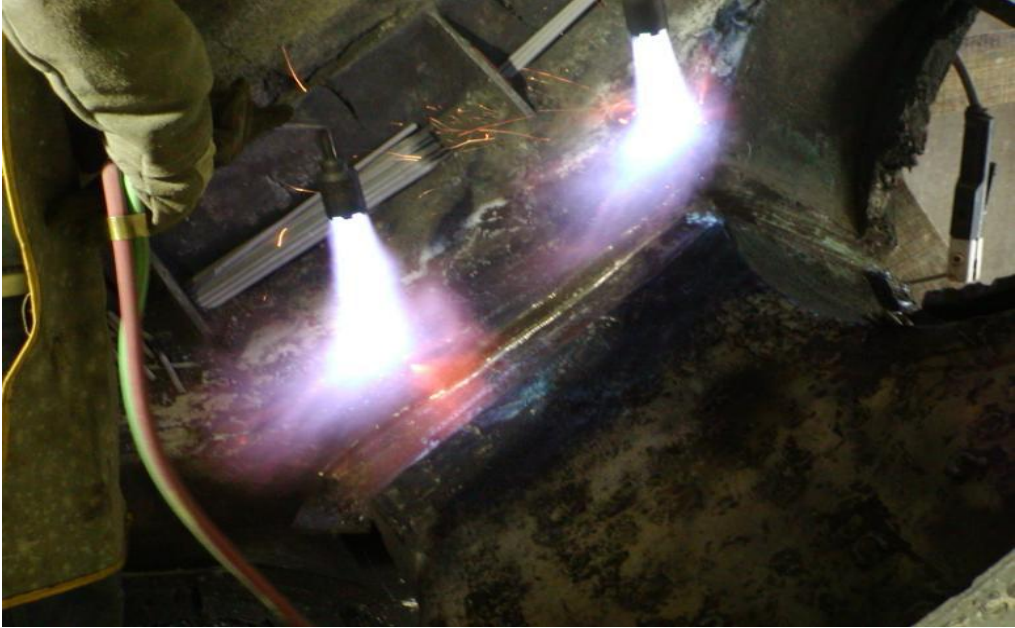
Fig. 6. Mantenimiento de la temperatura durante el proceso de soldadura
