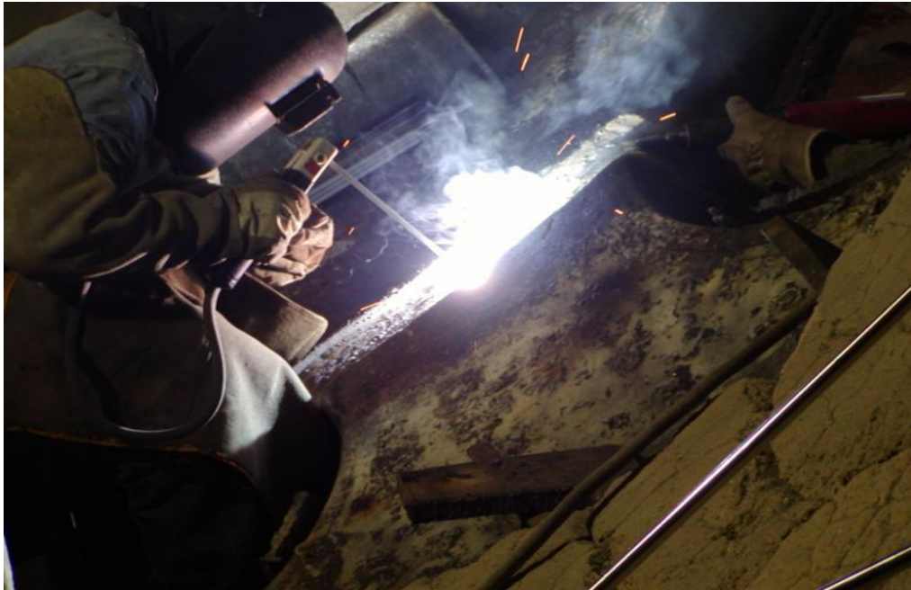
Fig. 7. Aplicación de la soldadura. Posición Vertical Descendente
