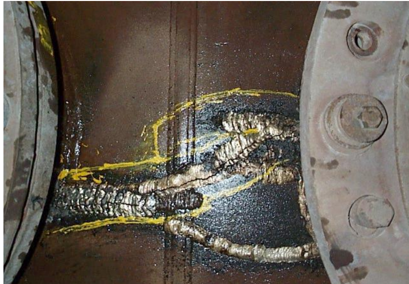
Fig. 1. Fallas en las soldaduras de acero austenítico.
